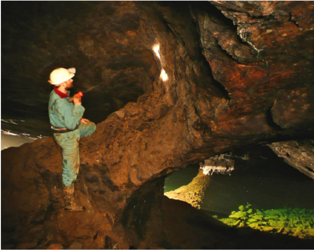
Abb. 10: Stützfeiler und Weitungsbaue im Mutter Gottes Lager (Archiv Norbert Kaiser, Foto 2008).
