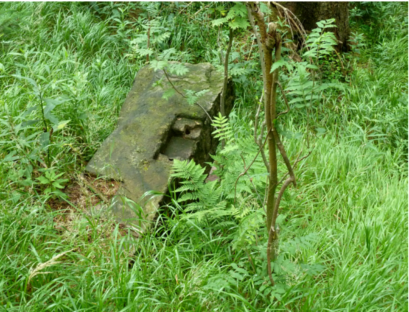
Abb. 11: Einstige Wellenauflage des Kunstrades der Eisenzeche Segen Gottes (aus Pflug 2013).
